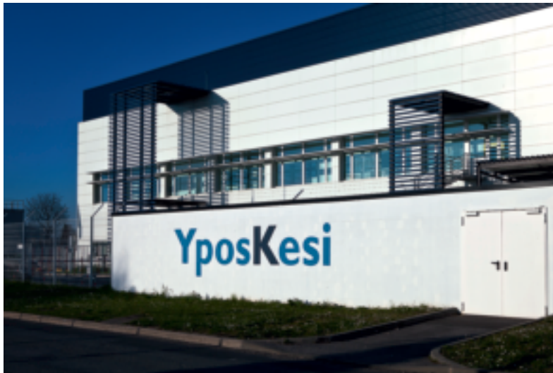
Bâtiment Yposkesi (© Christophe Hargoues)
